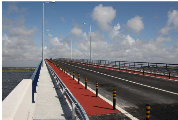
Figura 11 – Vista superior do tabuleiro após alargamento
