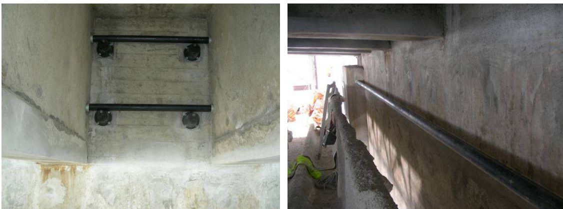
Figura 9 – Pré-esforço transversal e barras de pré-esforço longitudinal nas carlingas dos apoios e pré-esforço transversal dos capiteis de apoio das novas vigas
