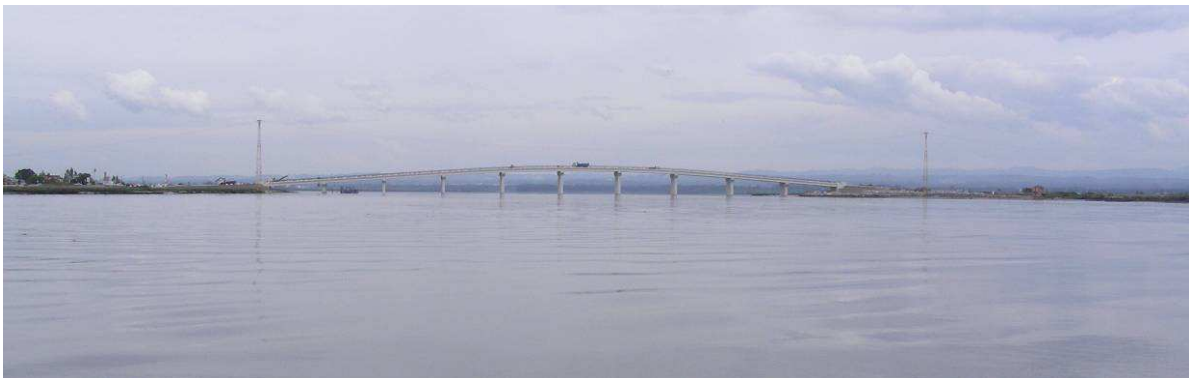
Figura 12 – Vista geral da obra após intervenção
