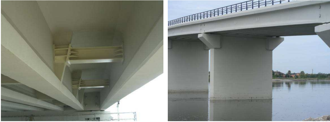
Figura 10 – Alargamento das carlingas dos vãos com perfis metálicos e obra após protecção superficial
