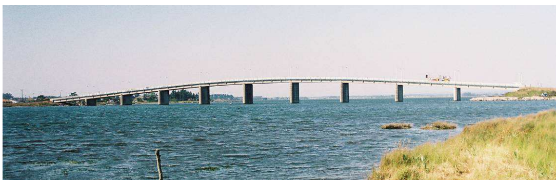
Figura 1 – Ponte da Varela, antes da intervenção
