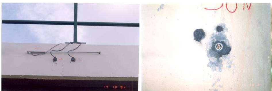
Figura 12 Alongâmetros e sensores de resistividade instalados nas “Estacadas”
