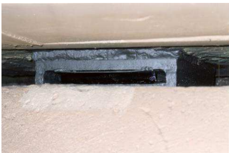
Figura 9 Reabilitação dos aparelhos de apoio no encontro Sul das estacadas
