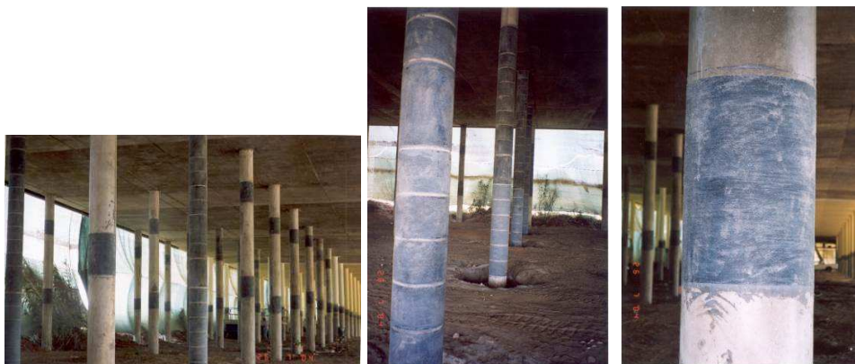
Figura 8 Encamisamento de pilares/estacas com mantes de CFRP
