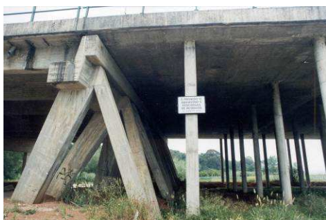
Figura 3 Pilar de transição do viaduto E para as estacadas
