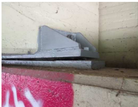
Figura 11 Substituição da fixação das vigas do tabuleiro à viga de estribo do encontro
