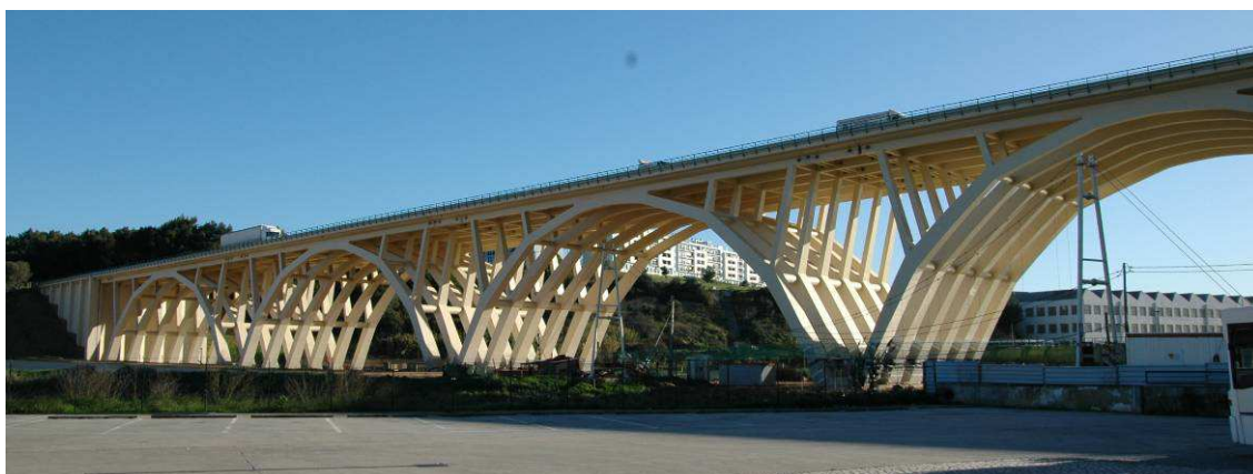
Figura 1 – Vista geral do Viaduto sobre o Rio Trancão
