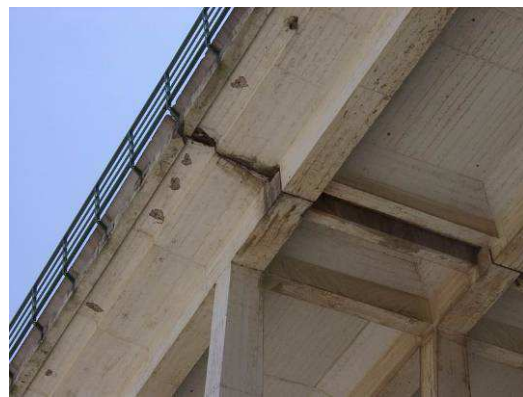
Figura 2 – Escorrências de água nas juntas estruturais do tabuleiro e delaminações locais nas consolas
