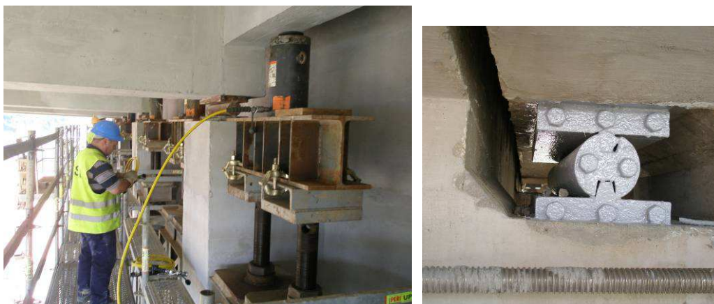
Figura 10 – Sistema de levantamento do tabuleiro para substituição dos aparelhos de apoio nos encontros e reabilitação dos apoios dos tramos simplesmente apoiados do tabuleiro.
