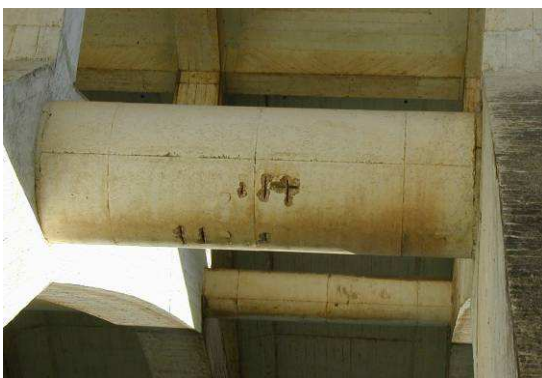
Figura 4 – Corrosão de armaduras nos contraventamentos e fendilhação do pavimento betuminoso
