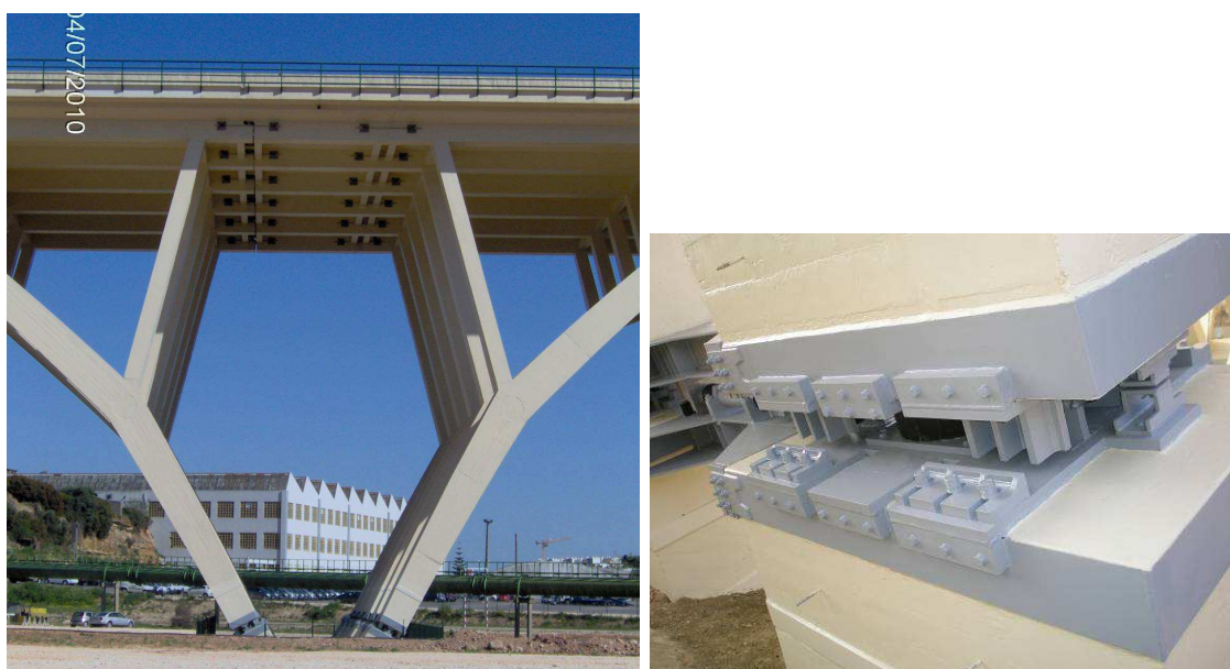
Figura 12 – Vista dos sistemas de isolamento de base e continuidade do tabuleiro
