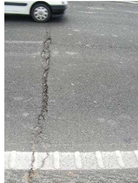
Figura 4 – Corrosão de armaduras nos contraventamentos e fendilhação do pavimento betuminoso
