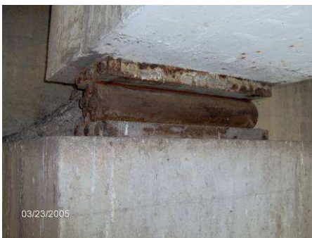
Figura 3 – Aparelhos de apoio nos encontros e nas juntas intermédias do tabuleiro com corrosão
