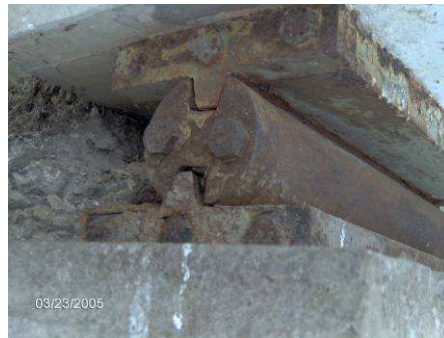
Figura 3 – Aparelhos de apoio nos encontros e nas juntas intermédias do tabuleiro com corrosão
