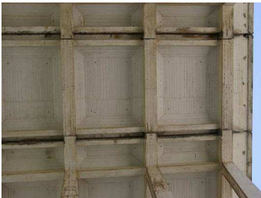
Figura 2 – Escorrências de água nas juntas estruturais do tabuleiro e delaminações locais nas consolas
