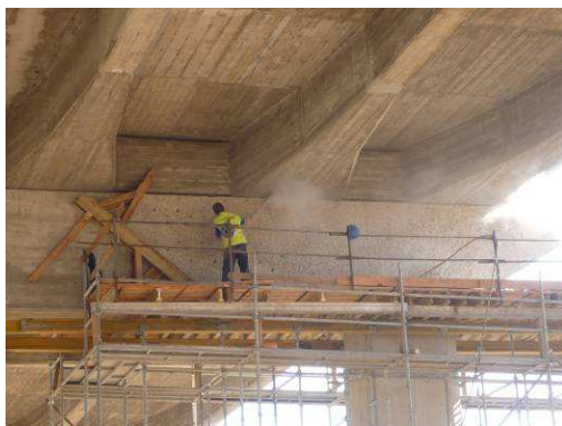
Figuras 21 e 22. – Preparação da superfície do betão para alargamento da travessa existente e Reforço das vigas com CFRP sobre o caminho de ferro.
