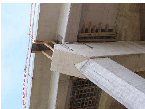
Figuras 27 e 28. – Detalhe da extremidade das travessas sobre a qual ainda está a cofragem na ligação "in-situ" entre topos de vigas e Aspecto do viaduto após alargamento (lado poente).
