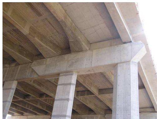
Figuras 23 e 24. – Ligação entre viga pré-fabricada e o tabuleiro existente junto a reforço com CFRP e Aspecto de um pilar corrente e tabuleiro após o alargamento finalizado.
