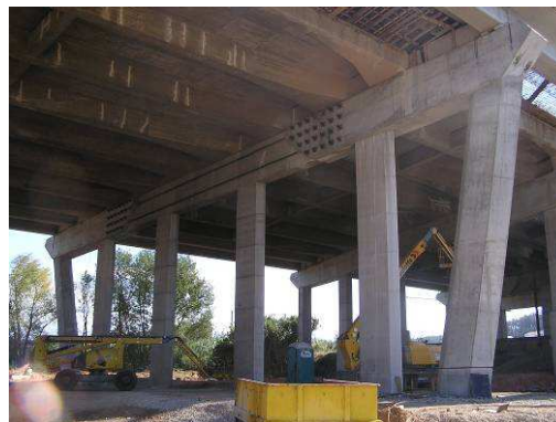
Figuras 25 e 26. – Pilar P7 e Pilar P10 após alargamento.
