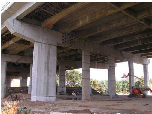
Figuras 25 e 26. – Pilar P7 e Pilar P10 após alargamento.
