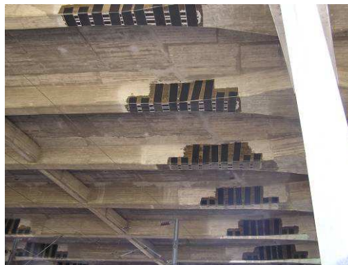
Figuras 21 e 22. – Preparação da superfície do betão para alargamento da travessa existente e Reforço das vigas com CFRP sobre o caminho de ferro.
