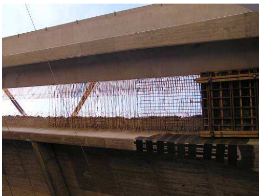
Figuras 23 e 24. – Ligação entre viga pré-fabricada e o tabuleiro existente junto a reforço com CFRP e Aspecto de um pilar corrente e tabuleiro após o alargamento finalizado.
