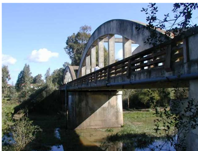
Figura 1 Ponte dos Arcos Vista geral
