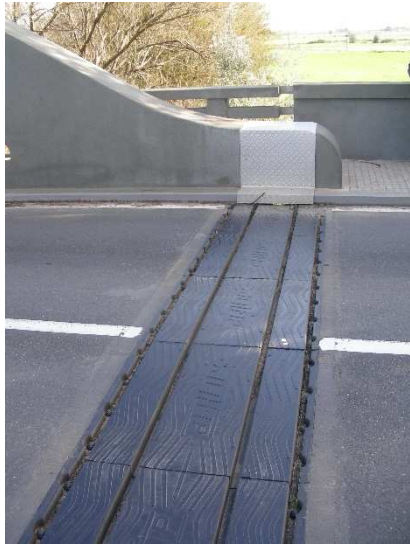
Novas cobrejuntas nos encontros e sobre o pilar
