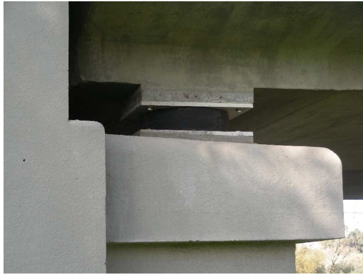
Figura 12 Novos aparelhos HDRB instalados na ponte
