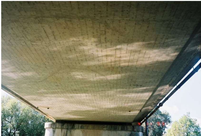
Figura 2 Vista da face inferior da laje do tabuleiro
