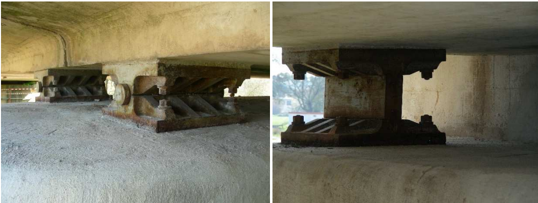
Figura 6 Aparelhos de apoio , fixos no pilar e móveis nos encontros
