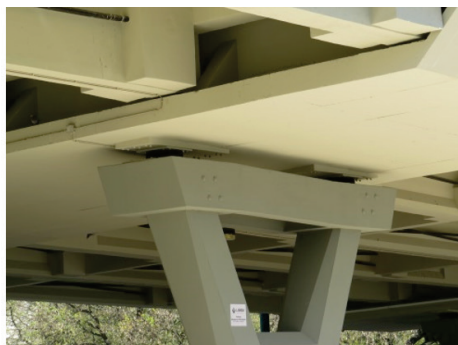
Figura 3 - Vista da obra após introdução do isolamento de base
